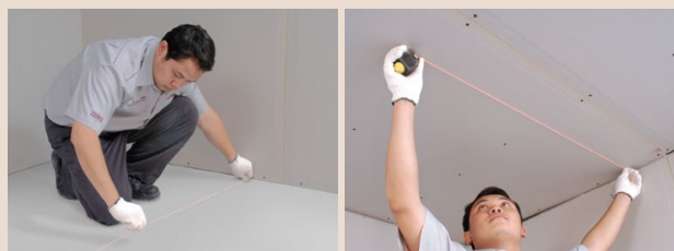
1 กำหนดแนวพ่นไวท์ที่พื้นและฝ้าเพดาน
