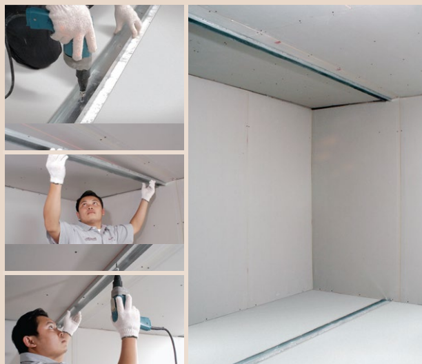
2 ติดตั้งโครงคร่าวตัว U ที่พื้นและที่ฝ้าเพดาน โดยยึดด้วย พุกคอนกรีต ระยะห่างทุกๆ 60 ซม. โดยพุกตัวริมห่างจาก ปลายโครงไม่เกิน 5 ซม.
