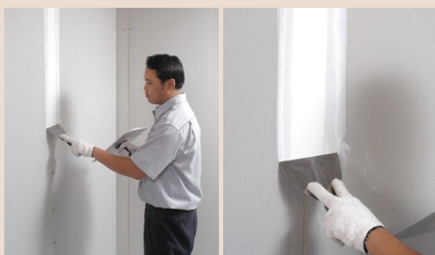
5 ฉาบปิดรอยต่อของแผ่นทุกด้าน 3 เที้ยว ตามมาตรฐานของ ตราช้าง ด้วยปูนฉาบรอยต่อ อีซี พลาส 120 ตราช้าง (EasyPlas 120) และผ้าเทป ตราช้าง
